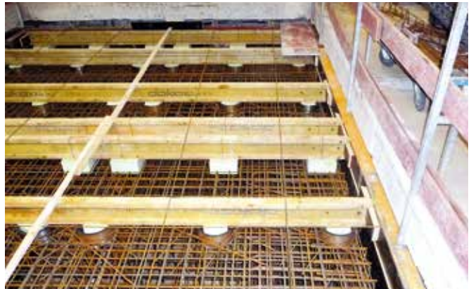
基础隔振钢筋锚杆系统
