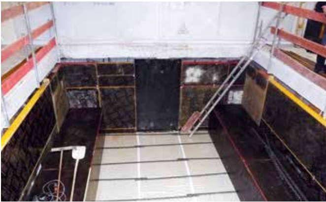
基础隔振模板工程
