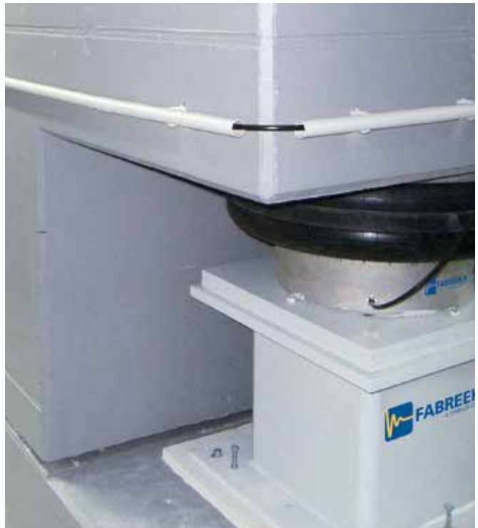
完工后的隔振基础
