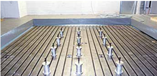
铁地板安装固定
