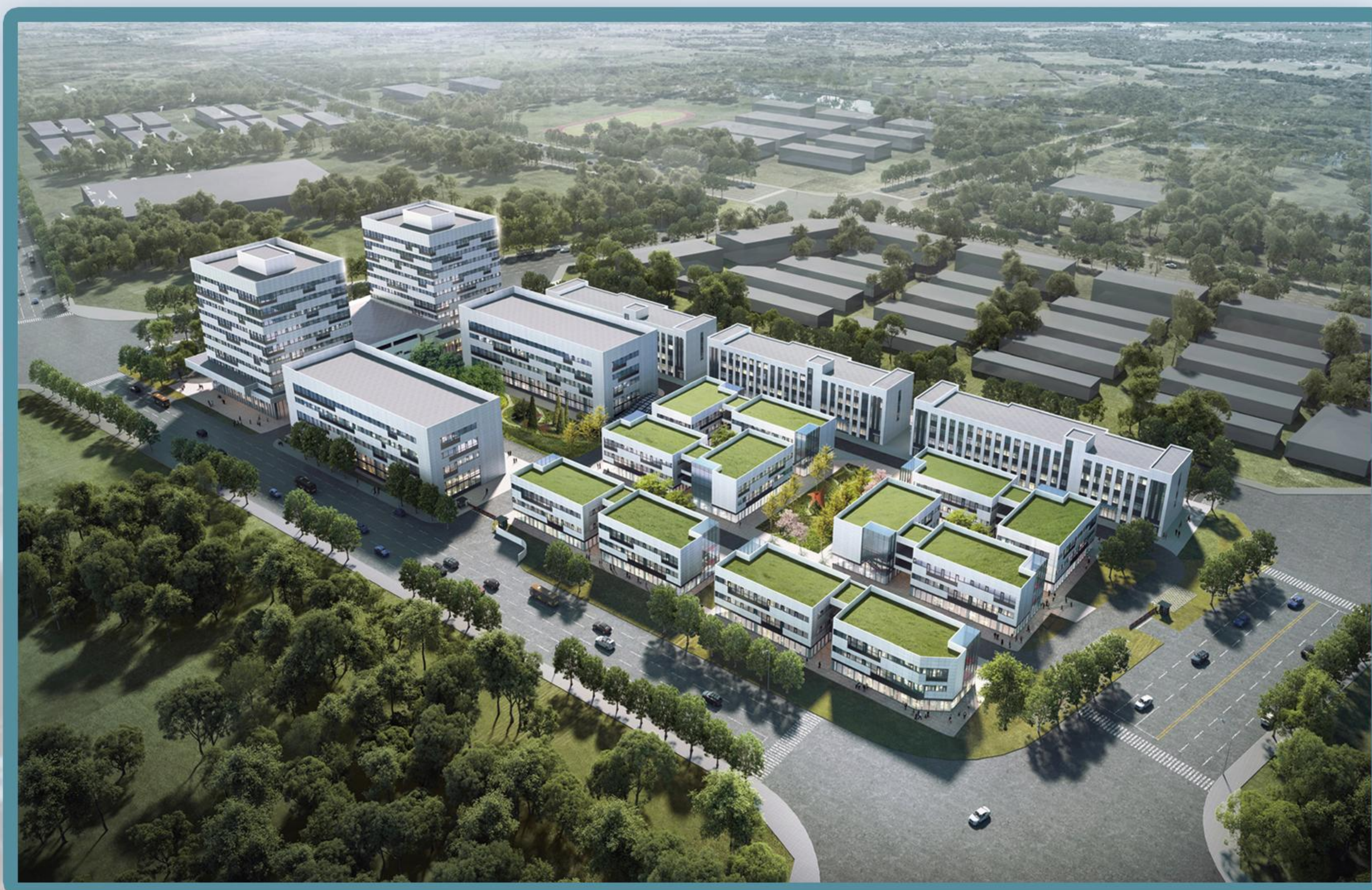
山东烯泰天工节能科技有限公司在建产业园
