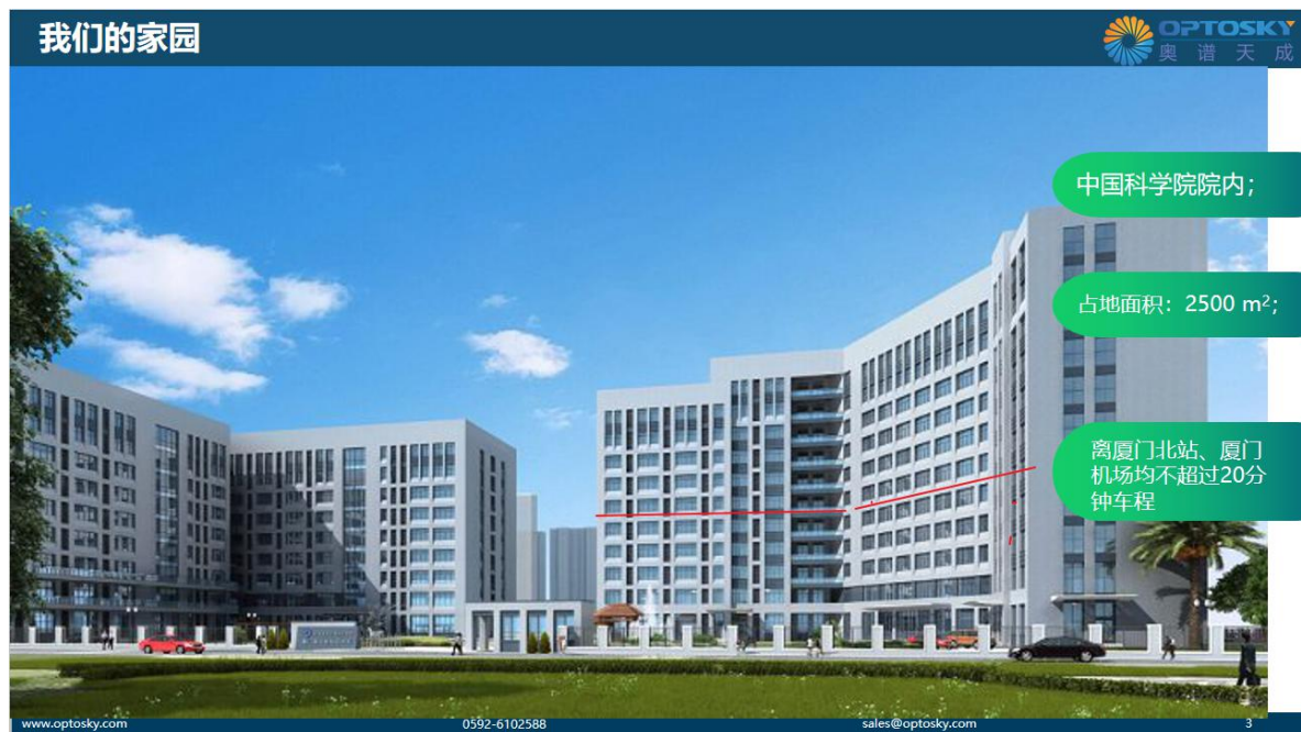
图 11 奥谱天成（厦门）光电有限公司，总部在风景秀丽的厦门，位于中国科学院厦门稀土材料研究所园区内，占地面积 2500 平方米，图中红线上方为奥谱天成的办公楼层
